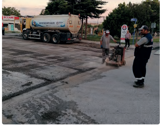
Hızarla Asfalt Kesme Çalışması
