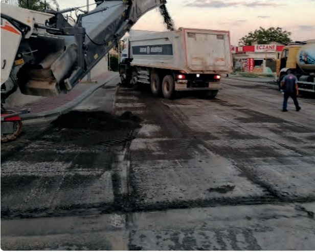
Trimerli Yol Kazısı
