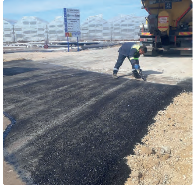
Yoğun Bakım Aracı ile Asfalt Yama Çalışmaları
