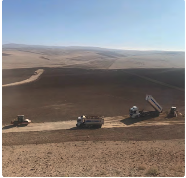
Stabilize Dolgu ile Yol Çalışması
