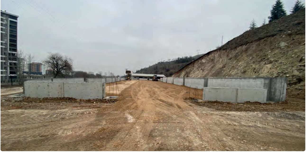
Hangar Yapım İşİ
