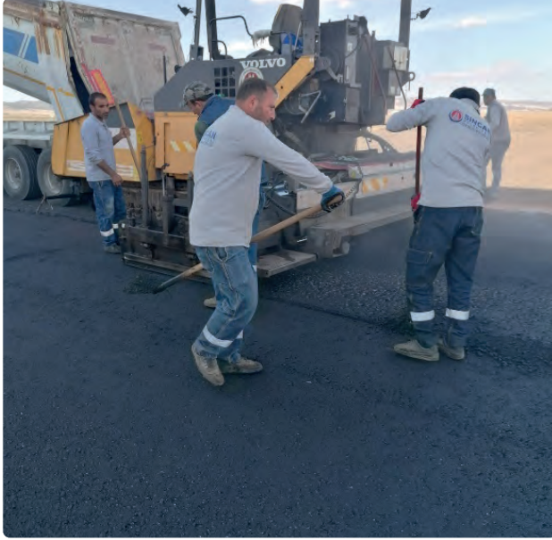
Finişer ile Asfalt Serme Çalışmaları
