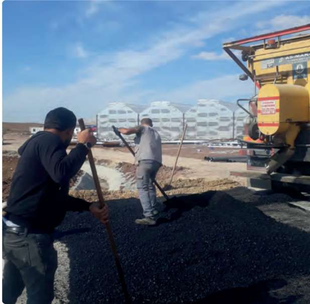
Yoğun Bakım Aracı ile Asfalt Yama Çalışmaları
