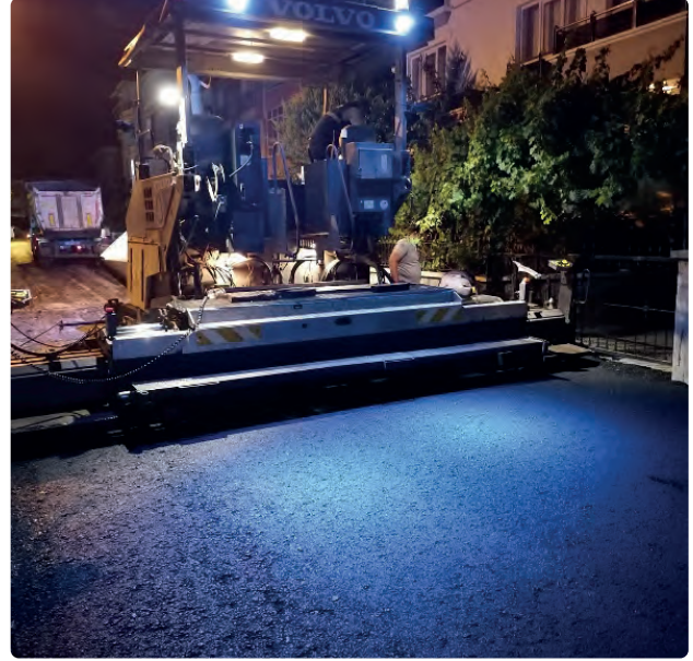
Finişer ile Asfalt Serme Çalışmaları
